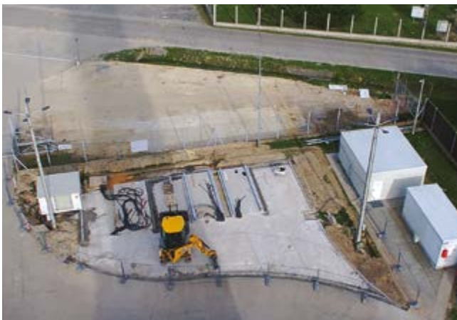
Tesseract energiatároló építése II. Fotó: MVM Balance Zrt.
