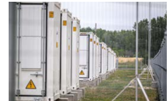
A szolnoki energiatároló moduljai Fotó: MAVIR ZRt.
