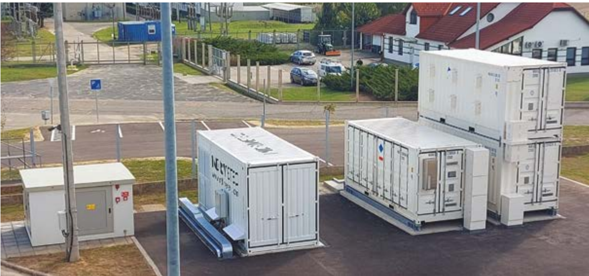
A Tesseract projekt főberendezései, balról jobbra haladva: segédüzemi BHTR, PCSU, 3 db akkumulátor konténer Fotó: MVM Balance Zrt.
