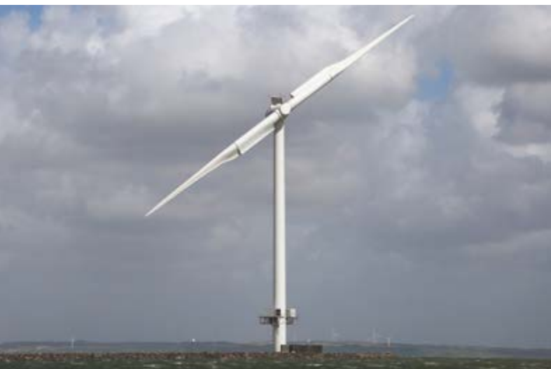
A kínai Envision Energy kétlapátos szélturbinája Fotó: Envision Energy
