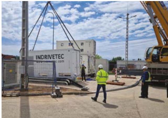
Tesseract energiatároló építése I. Fotó: MVM Balance Zrt.
