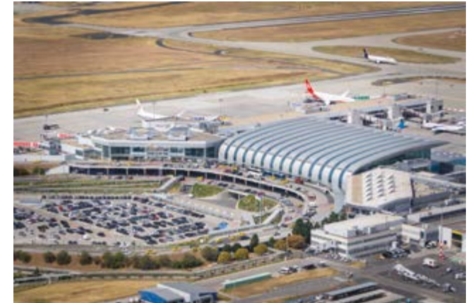
A Liszt Ferenc Nemzetközi Repülőtér Fotó: Budapest Airport Zrt.
